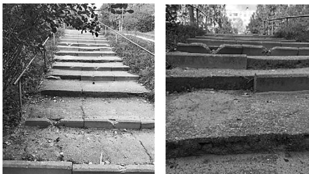
Рис. 1 – Пример лестницы с сильным износом
