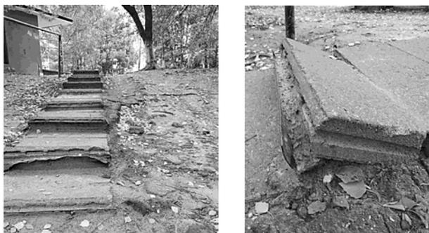
Рис. 2 – Пример лестницы с травмоопасными элементами
