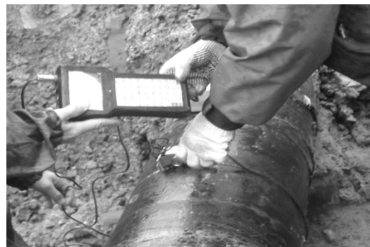
Рис. 9. Выполнение диагностики методом магнитной памяти металла
