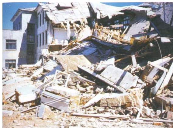
Рис. 5. Разрушенная при землетрясении школа, п. Нефтегорск, 1995 г [5]
