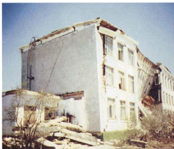
Рис. 2. Последствия землетрясения в п. Нефтегорске 28 мая 1995 г [4]
