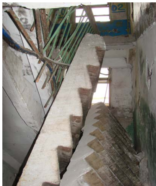
Рис. 6. Внутренние и внешние разрушения жилого дома, г. Невельск, 2007 г [6]
