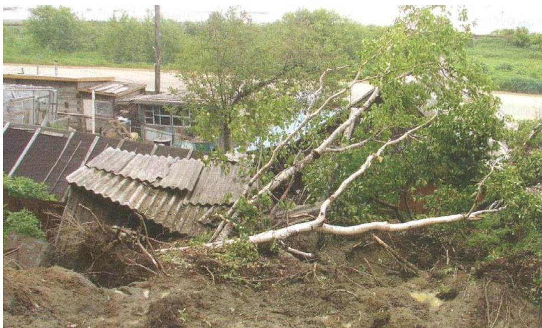
Рис. 9. Последствия схода оползня. Разрушенные хозяйственные постройки и поврежденный жилой дом, г. Макаров, ул. Набережная [7]
